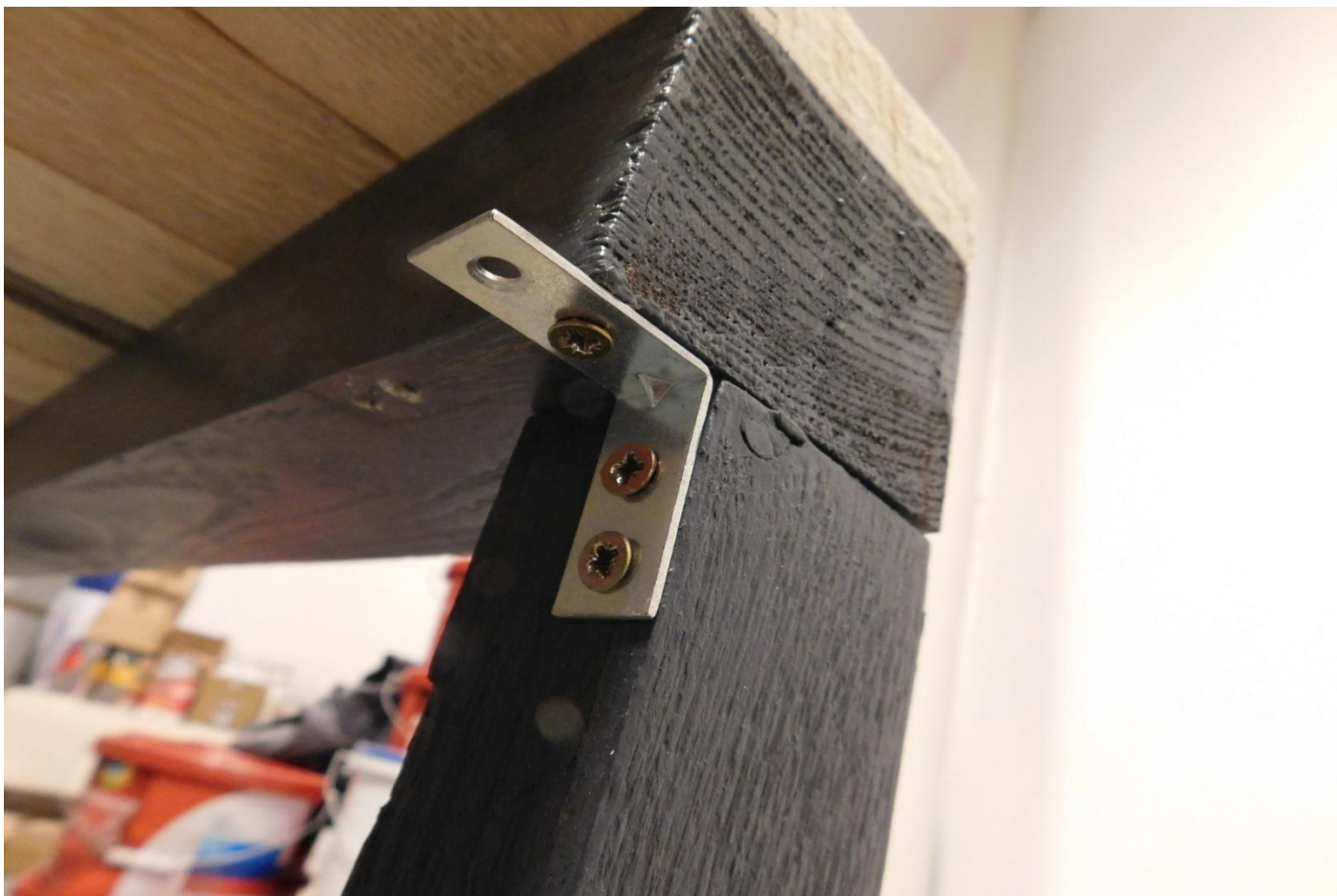
Spojení jednotlivých dílů zajistíme nábytkářskými profily. Kovové díly přetřeme Balakrylem UNI tmavě šedým.
